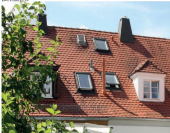
Abb. 61: Das Beispiel zeigt eine gelungene Verschalung einer Walmdachgaube - aber auch, wie unterschiedliches Dachzubehör fremd auf dem Dach wirken kann. Gerade die verschiedenen Dachdurchlässe stören (neben den Dachflächenfenstern) erheblich. Idealerweise sind hier Formziegel zu verwenden - zu sehen z.B. im rechten oberen Bildausschnitt direkt neben dem Kamin.
