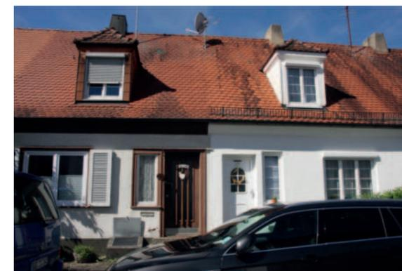
Abb. 38: Das sanierte Beispiel rechts zeigt einige unbedachte Gestaltungsdetails, die das historische Bild stören: Die Fenster wurden mit in die Scheiben integrierten Sprossen ausgeführt, statt Klappläden wurden Außenjalousetten angebracht, die Größe der Haustüre wurde leider verändert, diese entspricht auch nicht dem historischen Bild. Diese Details entsprechen nicht den Vorgaben der Satzung. Auch beim linken Haus fehlen die historischen Details.
