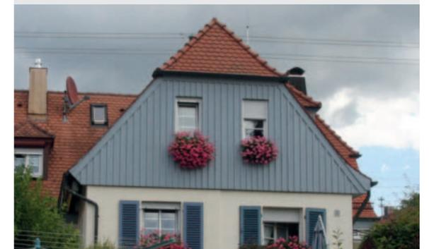
Abb. 59: Ein Dachabschluss mit einem Ortgang wird ausschließlich an den Giebelseiten der Hausarten mit einem Krüppelwalmdach benötigt. Dieses Beispiel zeigt einen Anbau, an dem der Abschluss mit einer Zahnleiste aus Holz erfolgt ist. So tritt vom Ziegel nur ein schmaler Anschnitt in Erscheinung.
