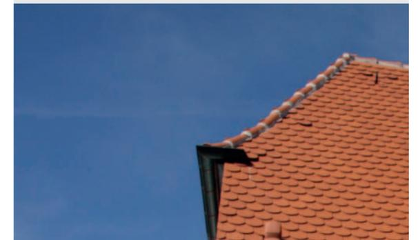
Abb. 58: Das Beispiel zeigt naturrote, nicht engobierte Biberschwanzziegel mit Rundbogenschnitt in Doppeldeckung. Die First- und Gratziegel wurden vermörtelt.
