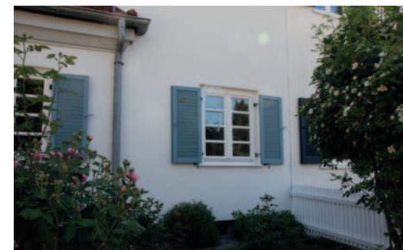
Abb. 104: Beispiel einer gut gelungenen, geringfügigen Dämmung. Bei der Sanierung wurden auch die Lage der Fenster verändert, dies hat zur Bewahrung der Proportionen beigetragen.
