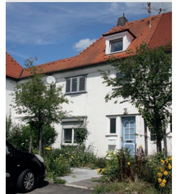
Abb. 31: Die Gebäude an der Umlandstraße verfügen teilweise auch heute noch über die historische Kastenfensterkonstruktion. Allerdings zeigt das Beispiel keine historische Fensterteilung. Ein Rollladen stört das Bild zusätzlich.
