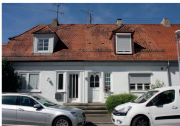
Abb. 54: In diesem Beispiel finden sich Walmdachgauben – rechts ist die Gaube G2 in der erhöhten Form zu sehen (hier leider auch mit einem Aussenrollladen), links wurde eine Gaube nachträglich realisiert – leider in der falschen Höhe (G3) und nicht mit einem 2-flügeligen Fenster. Dennoch zeigt das Beispiel, dass der Einbau einer Gaube einem Dachflächenfenster vorzuziehen ist. Allerdings sollte die für die Hausgruppe typische Gaube gewählt werden.
