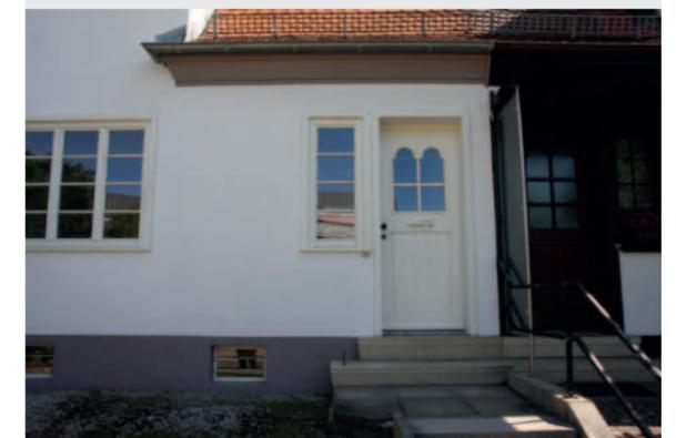
Abb. 25: in Putzstruktur und Farbe abgesetzter Sockel
