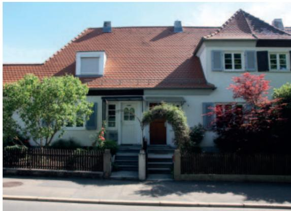
Abb. 53: Die Häuser zeigen die Flachdachgaube G4 (hier leider in Ausführung mit einem Aussenrollladen) sowie eine Wiederkehr (leider wurde auch diese mittig mit einem Blech geteilt).
