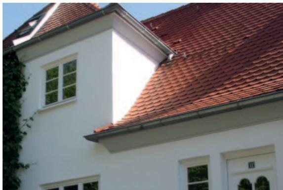
Abb. 51: Das Beispiel zeigt die Traufgestaltung sowohl am Hauptdach wie auch am Dach eines Zwerchhauses der Hausgruppen IV-VII. Die Dachsanierung ist hier gut gelungen. Störend wirkt allerdings der Übergang zum Nachbarn - hier wurde aufgrund verschiedener Aufbauhöhen eine Blechkante eingebaut. Sollte der Nachbar ebenfalls das Dach sanieren, wäre der Entfall sehr wünschenswert.
