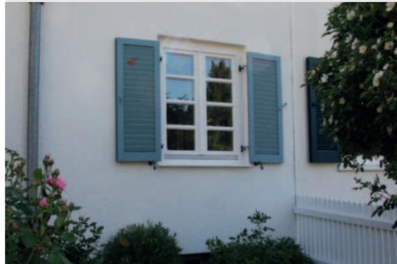
Abb. 35: Das Beispiel zeigt die Lamellenform zur Straßenseite. Gut gelungen ist hier auch die Holzfensterbank. Zu beanstanden ist lediglich das Anbringen der Klappläden - da eine Fasche fehlt (sowohl in Holz wie auch in Putz), musste der Klappladen am Fensterrahmen befestigt werden.
