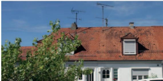
Abb. 62: Das Beispiel zeigt noch vorhandene Antennenanlagen, die mittlerweile keine Funktion mehr haben. Diese wären bei einer Dacherneuerung zurückzubauen (Hinweis: Dies würde auch für den Vorbaurollladen an der Walmdachgaube gelten).
